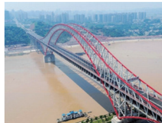
世界最长拱桥重庆朝天门长江大桥（鞍钢高性能 Q420qD）
