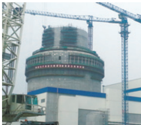
鞍钢 SA-738Gr.B 钢板应用于海阳一期核电工程
