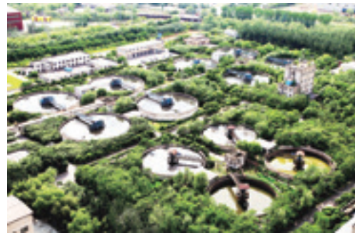
鞍钢股份能源管控中心西大沟废水处理系统
