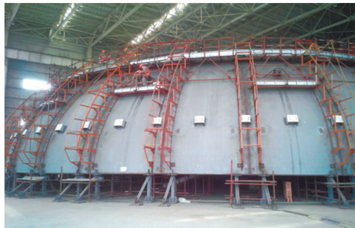
鞍钢 SA-738Gr.B 钢板应用于海阳一期核电工程
