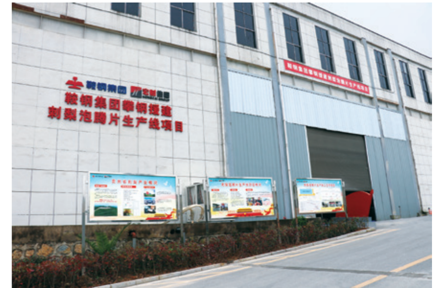
盘州市刺梨泡腾片项目厂房
