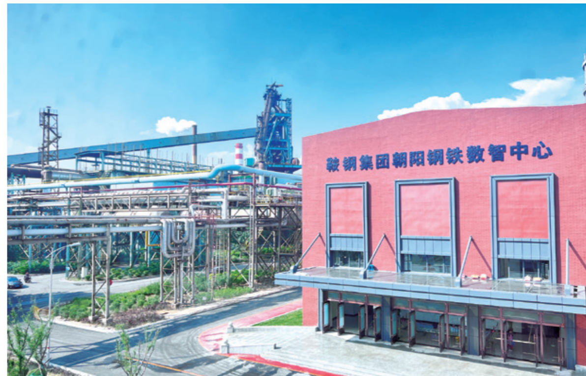
鞍钢集团朝阳钢铁数智中心
